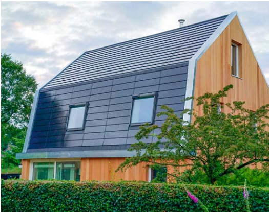
Planum PV – Flächennutzung auf Walm- und Zeltedächern. © Dachziegelwerke Nelskamp
