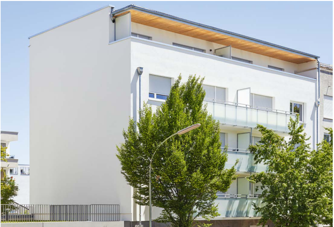
Das Gebäude in der Yorkstraße steht auf einem kleinen innerstädtischen Grundstück und hat eine Grenzbebauung auf drei Seiten. © Pforzheimer Bau und Grund GmbH
