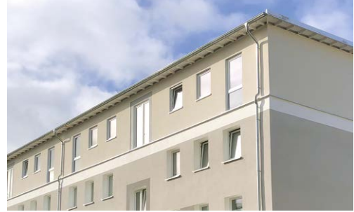
Dachaufstockung Mörikestraße 1-11, Essen
